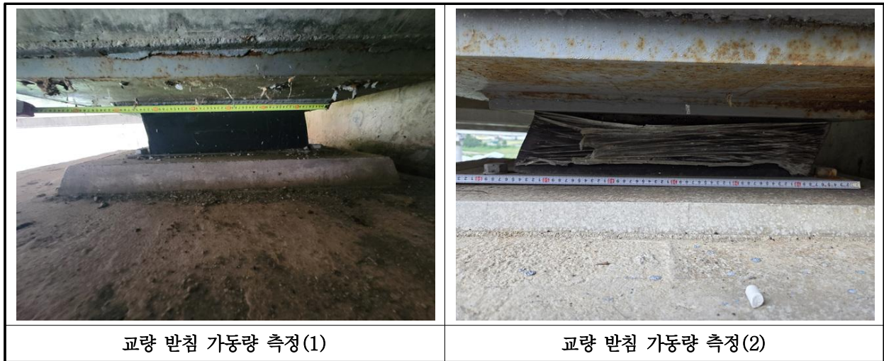
【사진 14.3.41】 교량받침 이동량 측정
