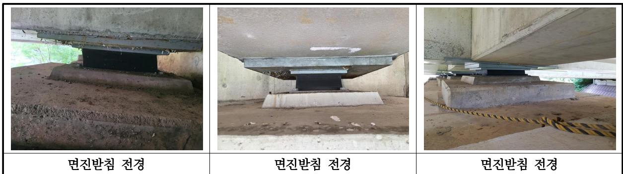
【사진 14.3.38】 교량받침 전경
