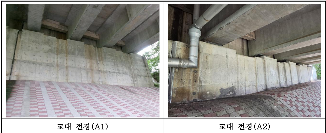
【사진 14.3.33】 교대 전경
