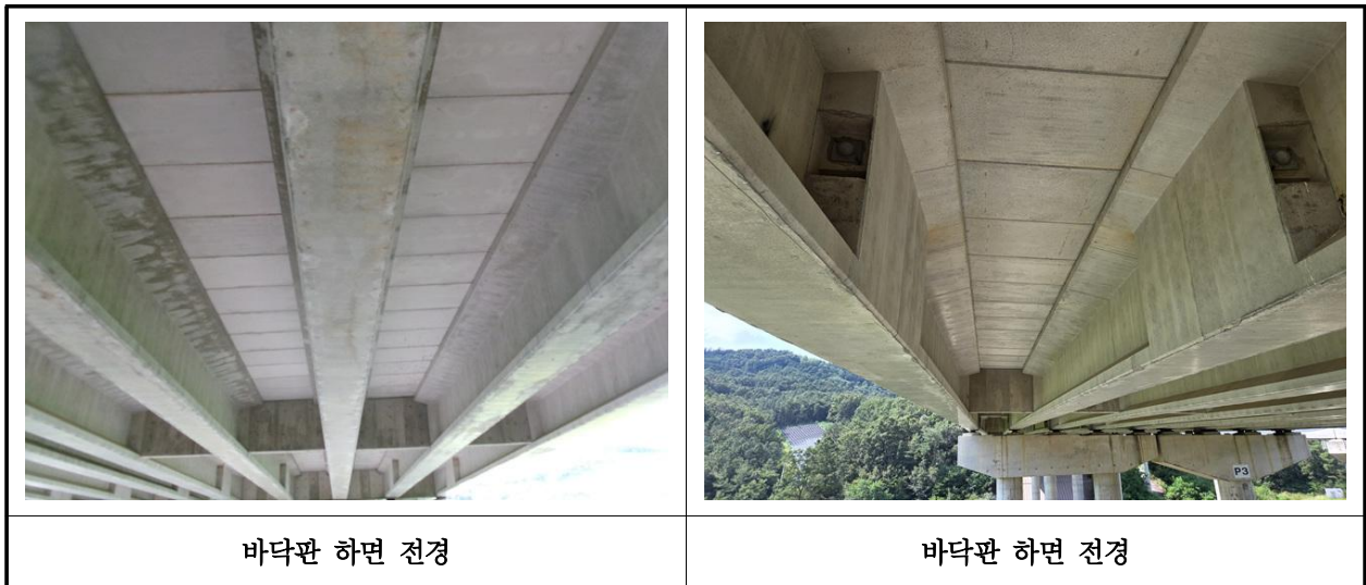
【사진 14.3.27】 바닥판하면 전경
