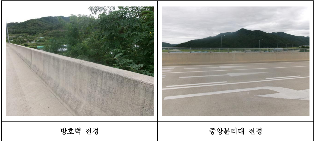
【사진 14.3.49】 방호벽 및 중양분리대 전경
