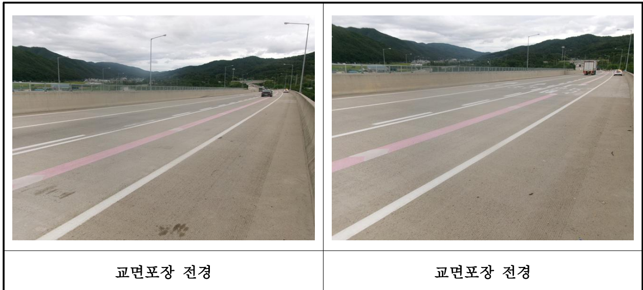
【사진 14.3.45】 교면포장 전경
