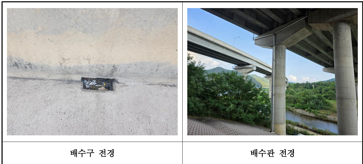
【사진 14.3.22】 배수시설 전경
