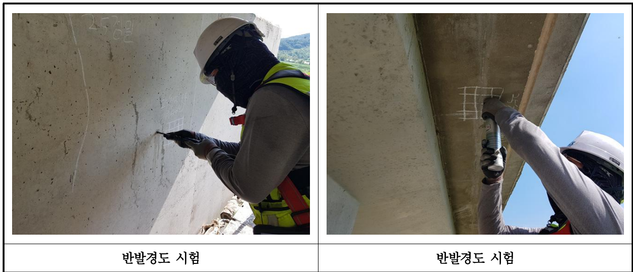
【사진 14.4.2】 반발경도시험 현장사진
