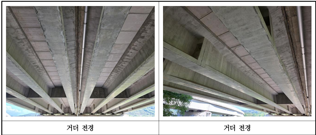
【사진 14.3.4】 거더 전경
