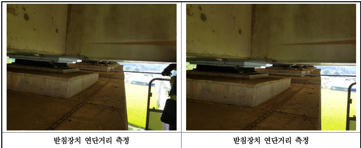
【사진 14.3.15】 교량받침장치 연단거리측정
