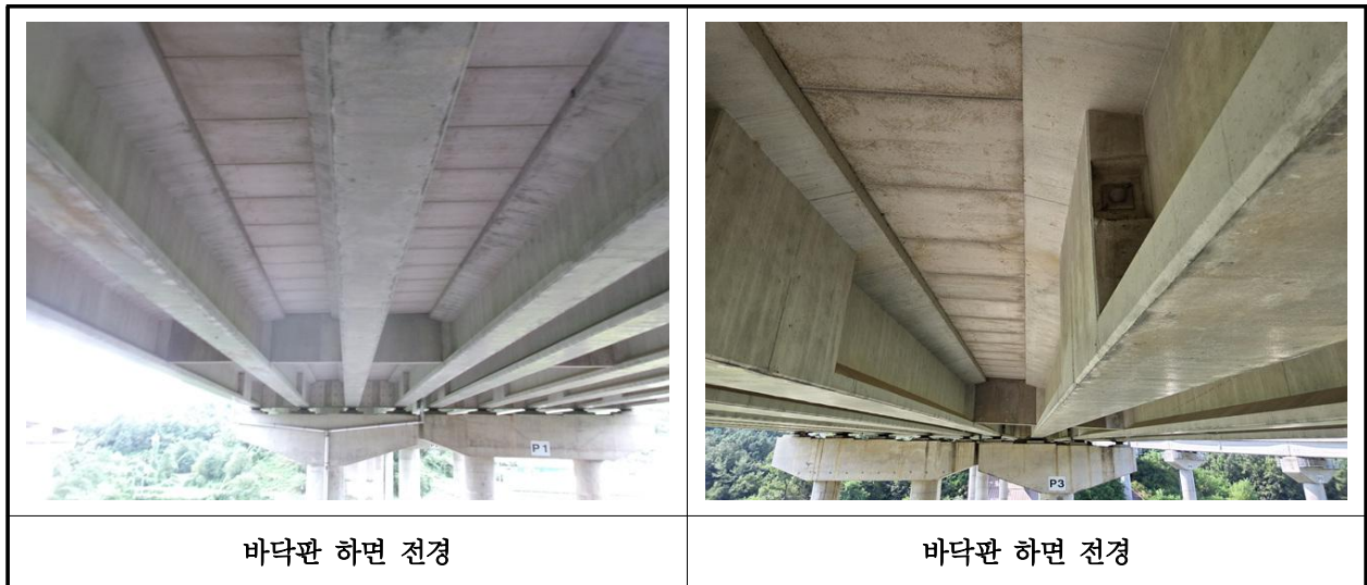
【사진 14.3.2】 바닥판하면 전경
